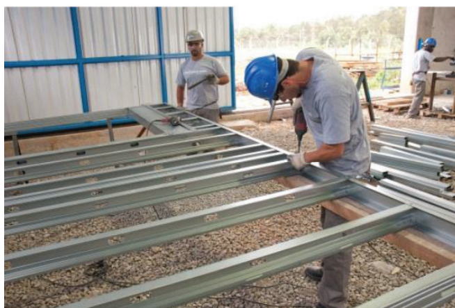
Figura 50: Sistema de painéis (Fonte: Construtora Micura)
