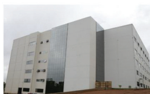
Figura 46: Fachada em light steel framing com vedação em Placas Cimentícias (Fonte: Saint-Gobain)
