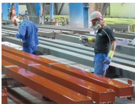
Figura 35: Aplicação de tinta com pistola sobre a estrutura (Foto: Sidnei Palatnik)
