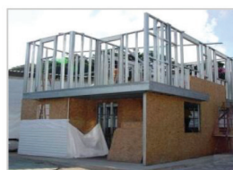
Figura 43: Vedação com Placas Cimentícias – MCMV – Paraná (Fonte: Saint-Gobain)
