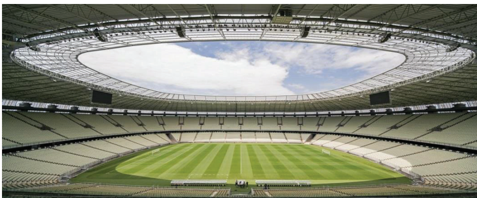
Figura 16: Grandes vãos – Arena Castelão (Foto: Leonardo Finotti)
