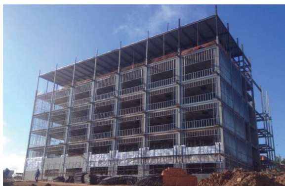
Figura 41: Edifício Educacional multi-pavimentos. Fachada em light steel framing (Fonte: Saint-Gobain)
